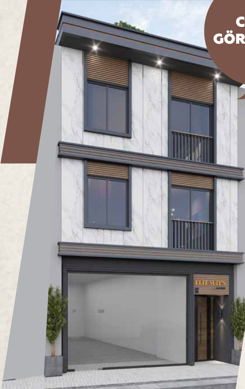
Demirciođlu Caddesi Cephesi
